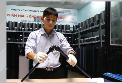
BƯỚC 8: HOÀN THÀNH LẮP ĐẶT
