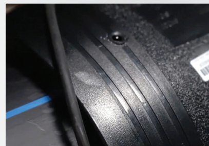
BƯỚC 11: MÁY HÀN THÔNG BÁO ĐÃ KẾT THÚC THỜI GIAN HÀN, HOÀN THÀNH MỖI HÀN.
