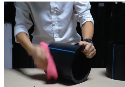
BƯỚC 5: LÀM SẠCH CÁC ĐẦU ỐNG VÀ PHỤ KIỆN
