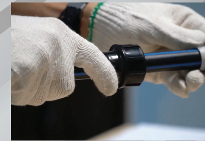
BƯỚC 5: LẮP TỨNG PHẦN CỦA PHỤ KIỆN
