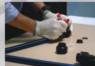
BƯỚC 4: ĐÁNH DẤU ĐỘ NGẬP CỦA ĐẦU ỐNG SAU KHI KIỂM TRA ĐỘ DÀI
