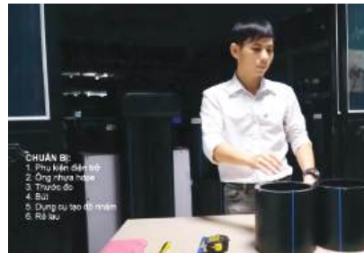
BƯỚC 1: CHUẨN BỊ PHỤ KIỆN, ỐNG, THUỐC, BÚT VÀ GIẤ Llau
