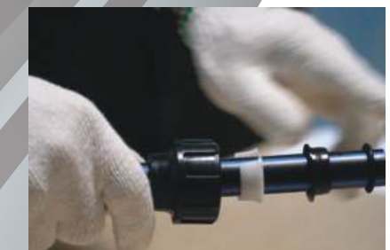
BƯỚC 6: ĐẨY GIOĂNG CHO ĐẾN KHI TỚI ĐỊA ĐIỂM ĐÃ ĐÁNH DẤU
